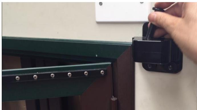
**INSERIRE IL PERNO ESAGONALE NEL MOTORE (FORNITO CON I BRACCI)**
